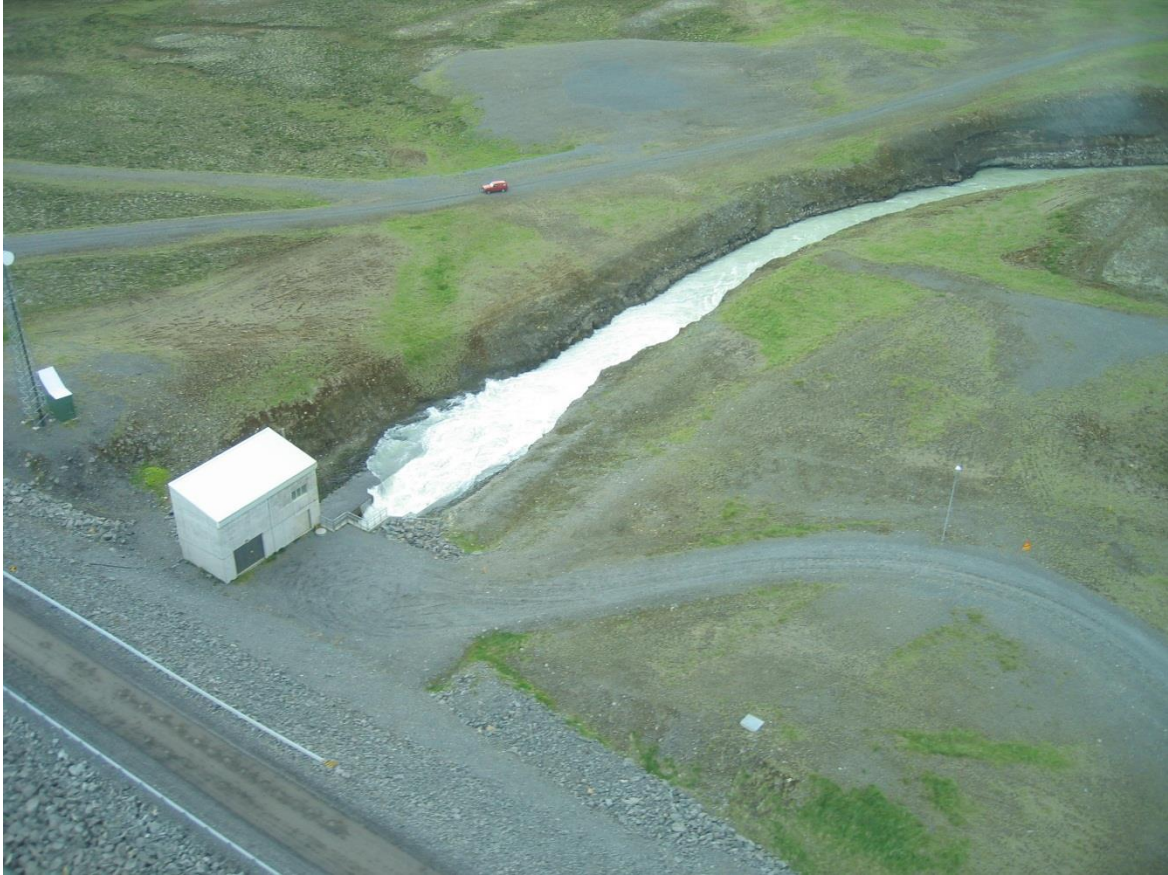
Mynd 30 Horft yfir Kolkuskurð og lokahús við Kolkustíflu. Mynd tekin úr lofti.
