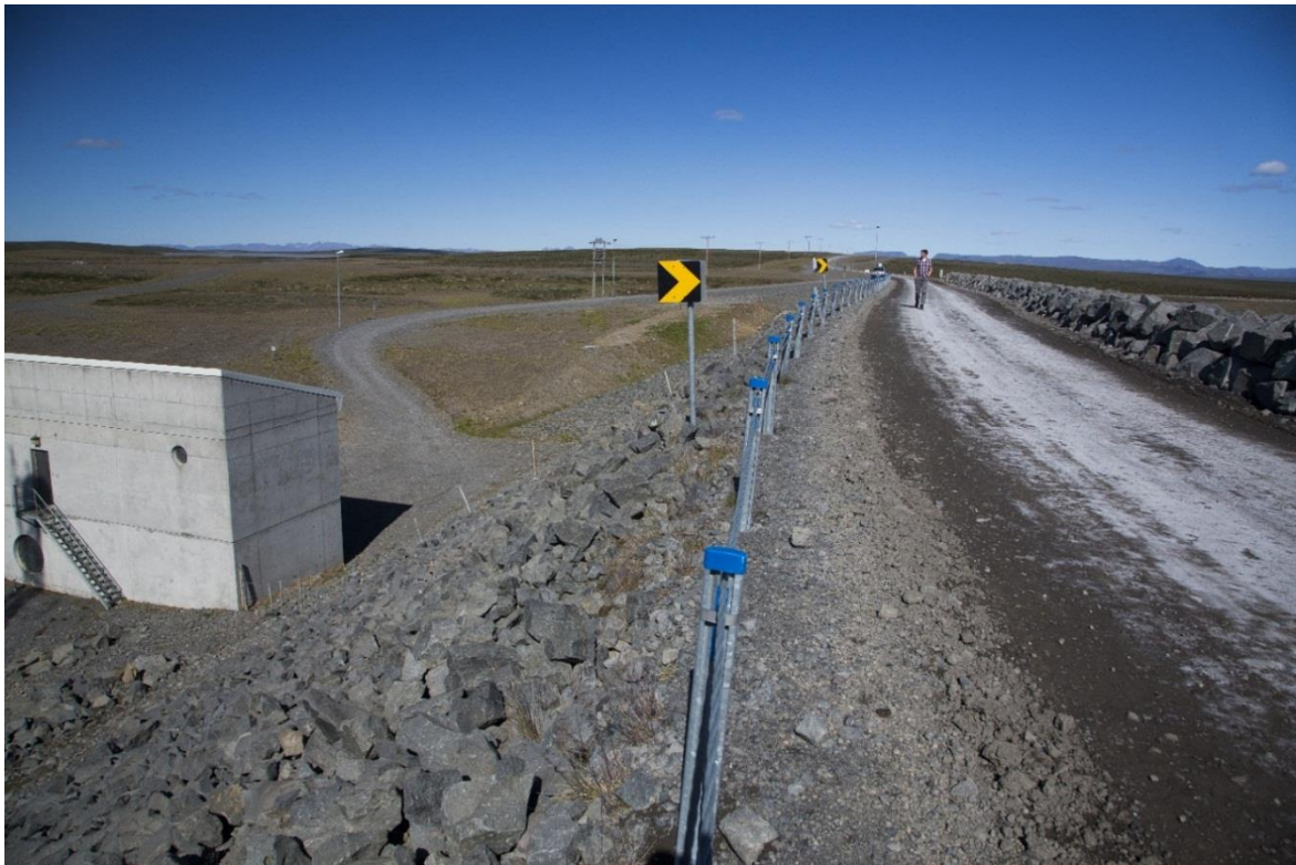
Mynd 41 Horft til norðausturs yfir Kolkustiflu, lokahús og aðkomuveg þess og í átt að fyrirhuguðu stæði Kolkuvirkjunar. Blöndulón til hægri ofan stíflugarðs.
