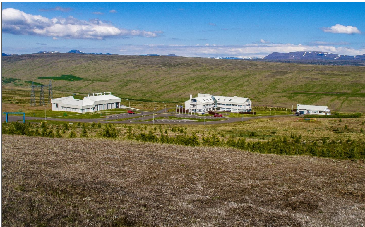
Mynd 3 Hús Blöndustöðvar í Blöndudal. Stöðvarhúsið er til vinstri á myndinni.
