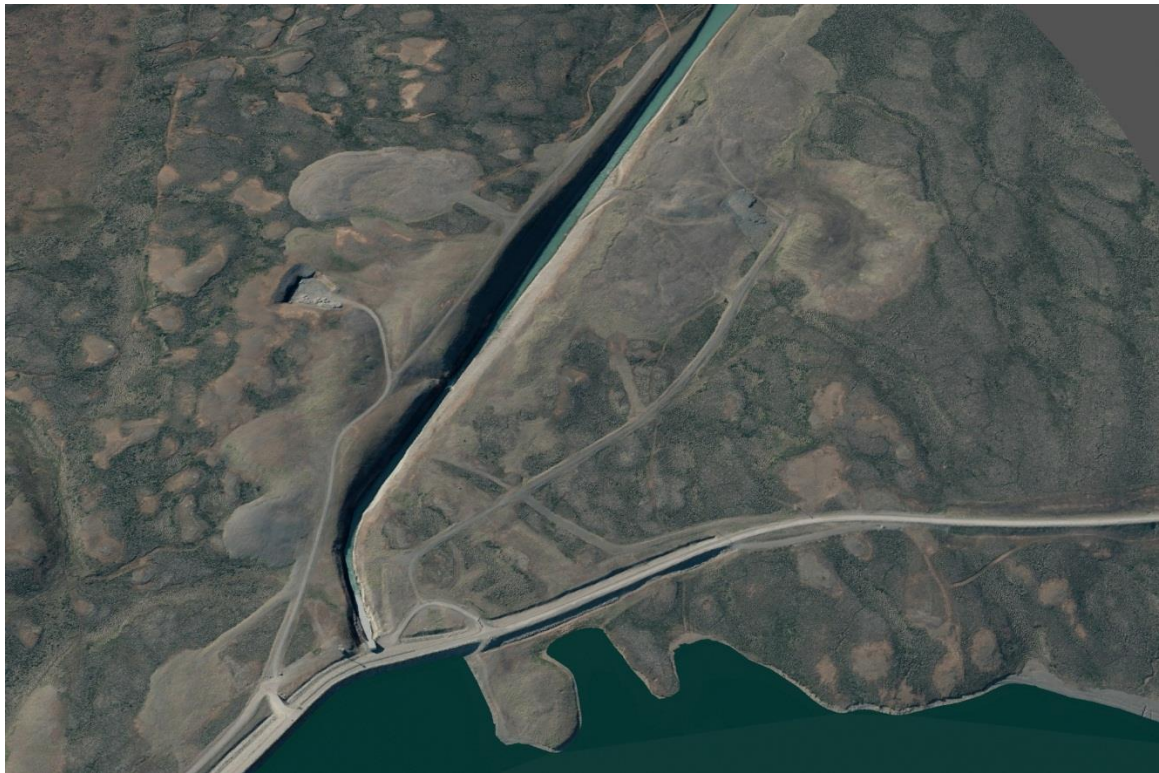
Mynd 45 Horft úr lofti til norðvesturs yfir Kolkustíflu, inntak og núverandi veituskurð. Blöndulón í forgrunni. Tölvugerð mynd.
