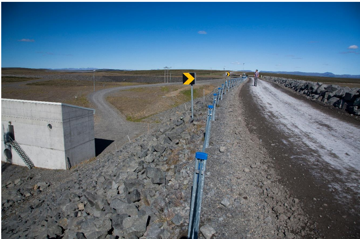
Mynd 42 Kolkuvirkjun. Sama sjónarhorn og að ofan. Sjá má frárennisskurð og óljóst má grilla í inntak virkjunar og efnislosunarsvæði. Stöðvarhúsið er niðurgrafið í skurðinn.
